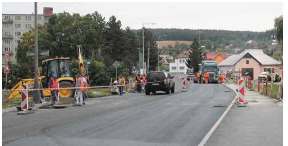
Rekonštrukcia frekventovanej Sládkovičovej ulice na začiatku jesene... Do konca tohto roka by mala byť megarekonštrukcia mestských komunikácií spoločnosťou Eurovia SK ukončená, celková hodnota diela je 1,61 milióna eur, v histórii mesta najviac za opravy ciest a chodníkov. Zodpovední vedúci pracovníci MsÚ prislúbili bližšie informácie poskytnúť Bánovčanom až v budúcom roku, po „administratívnom“ ukončení projektu...
