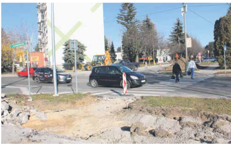
Rozkopaný vstup na priechod pre chodcov na frekventovanej križovatke na uliciach Sládkovičovej a Hollého... Kompletne informácie o ukončení tohto v histórii mesta najväčšieho projektu na rekonštrukciu mestských komunikácií, financovaného cez tzv. PPP projekt, poskytne mestský úrad až v budúcom roku... Mestské zastupiteľstvo odsúhlasilo na celé dielo sumu asi 1,4 milióna eur, ktoré bude mesto čerpať z úverových zdrojov... Foto: Alena Borszéková
