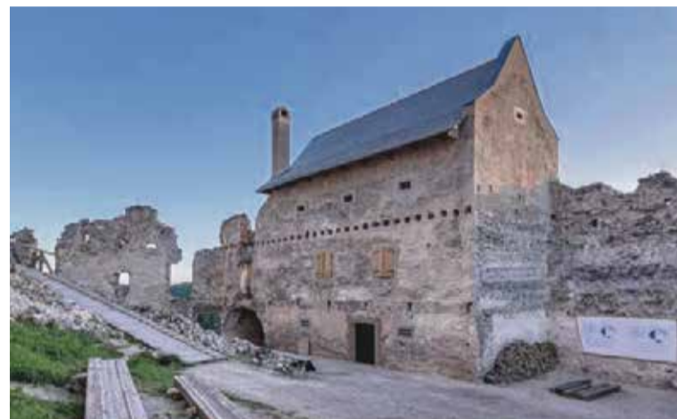
Hospodárska budova po komplexnej obnove.
