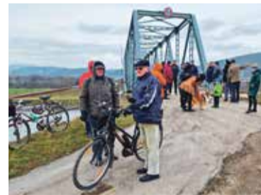
Začiatok výstavby mosta
